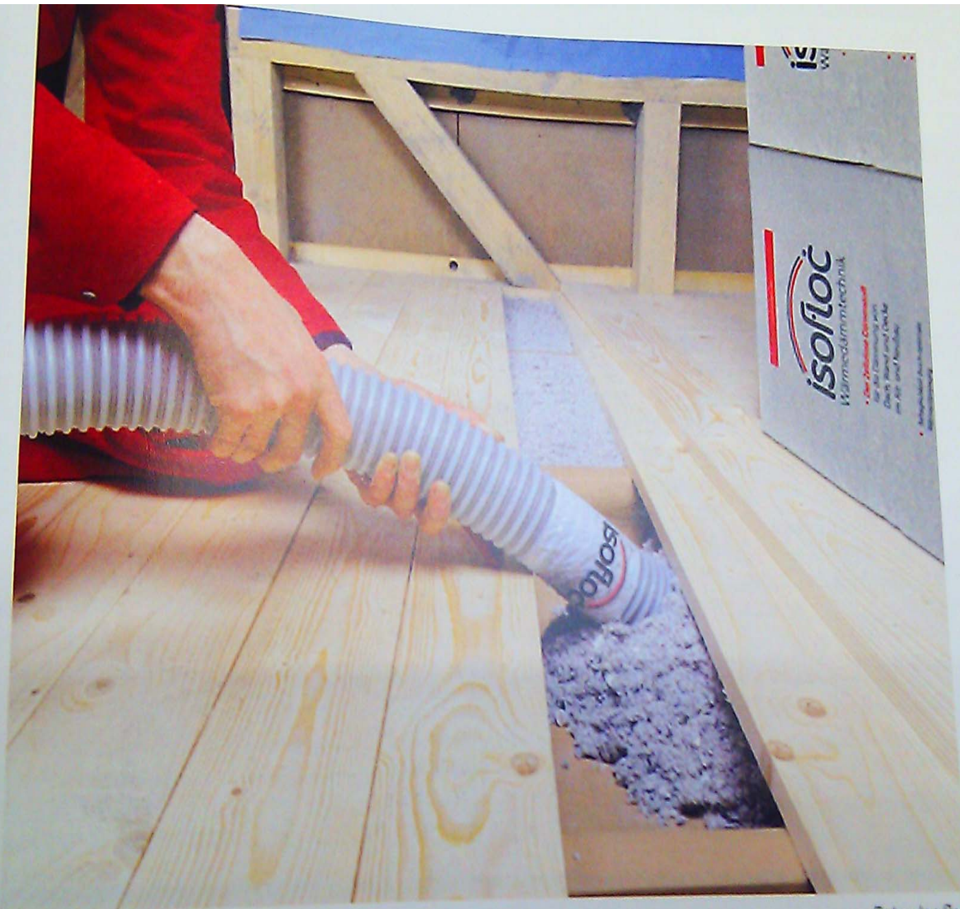
Nachträgliches Einblasen von Isofloc in Hohlräume
