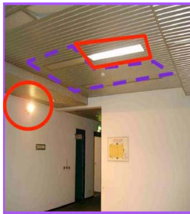
廊道採減光跳盞及感應式照明節電
