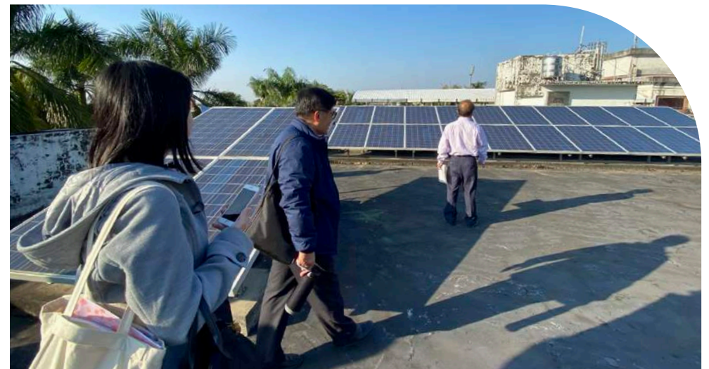
建物建置太陽能板的場地勘查
